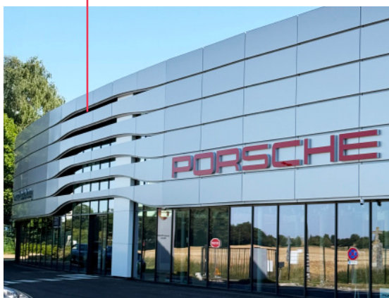
RIVETÉ ou VISSÉ / Immeuble de bureaux
