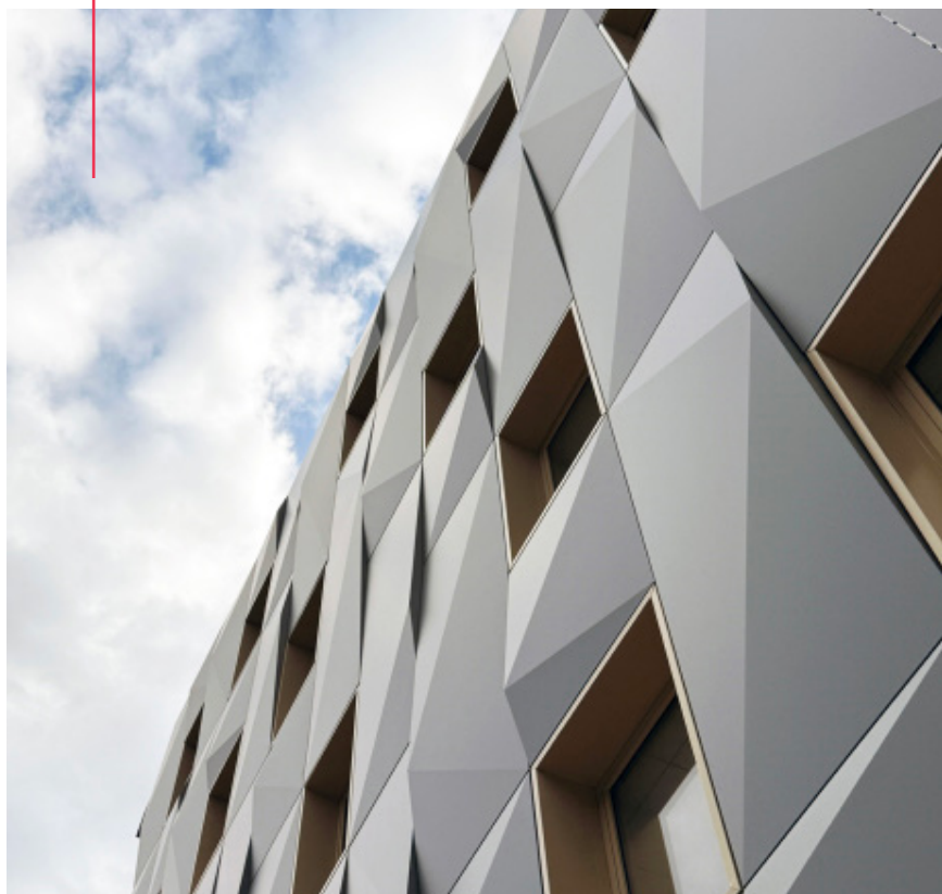
Immeuble de bureaux (63)
